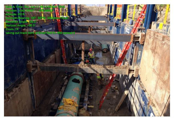
GREAT GULF DRIVE EAST (INSTALLING PNEUMATIC HAMMER TO BREAK BOULDER BLOCKING THE BORE)
