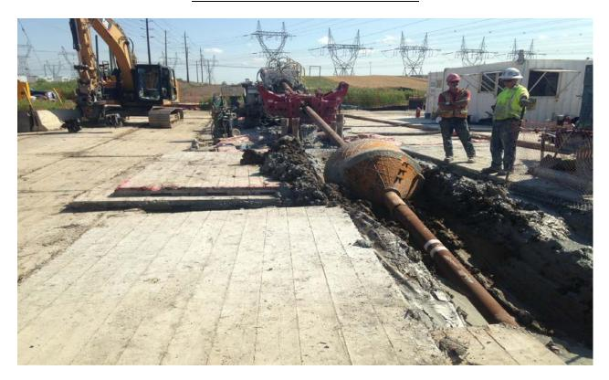
HIGHWAY 410 HDD - 6" PLASTIC BUOYANCY PIPE INSTALLED FOR PULLBACK
