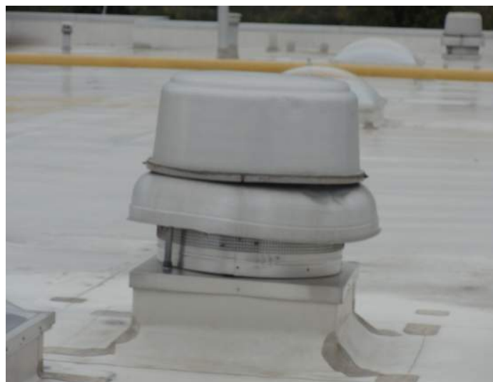
4. Roof Exhaust Fan
